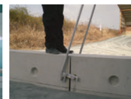
ジョイント作業
