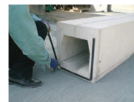
目地パッキン貼付
