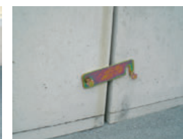
Pプレート・Pボルト取付
