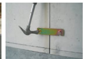
ボルトの固定
