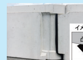
側面へのパッキン貼付
