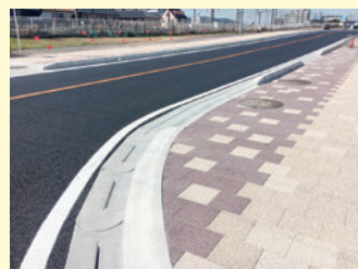
幸田町(県道) フレキシブルタイプ
