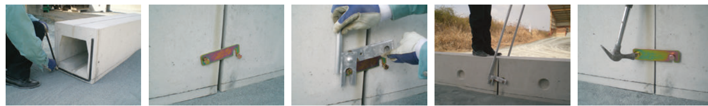
目地バックン貼付
