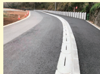
厚木市(市道) フレキシブルタイプ
