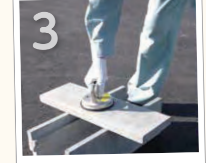
3 トラフから吸盤器具を外します
