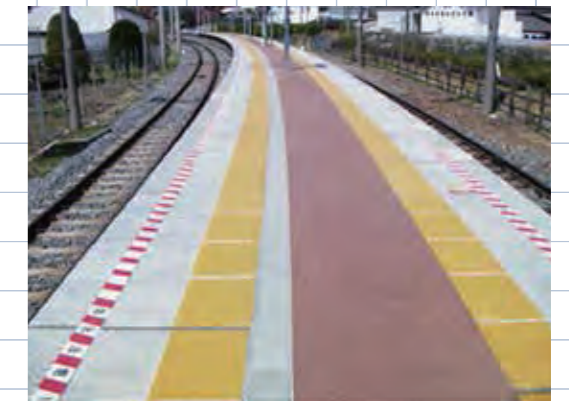
フラットな仕上がりなので、利用者にやさしい施工です。
