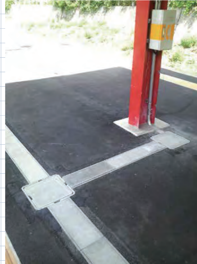
セキュリティトラフの役物には落ち蓋式ハンドホール。分岐もスッキリ。
