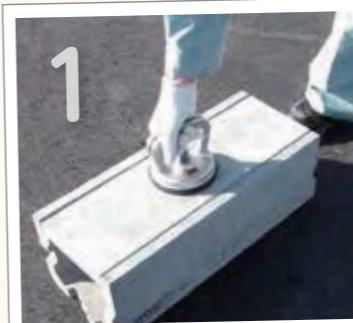
1 トラフに吸盤器具をセットします
