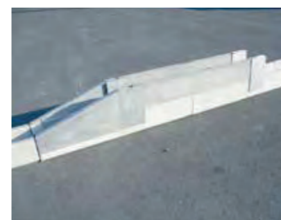
④嵩上げ板設置
