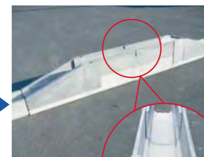
⑤ずれ止め金具設置
