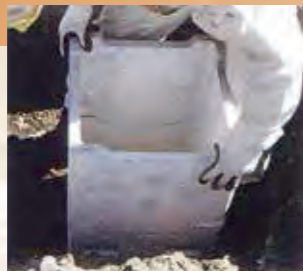
②基本ブロック(中段用)設置
