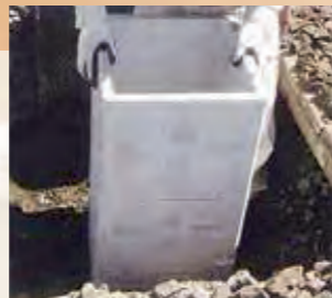
③基本ブロック(上段用)設置
