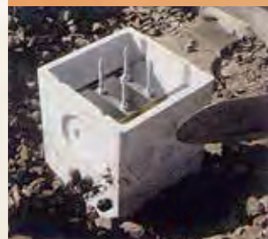
⑤埋め戻し及び簡易基礎ボルト設置
