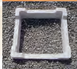
①穴を掘りベースブロックを配置する
