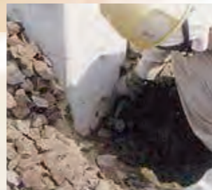
④ノック穴施工
